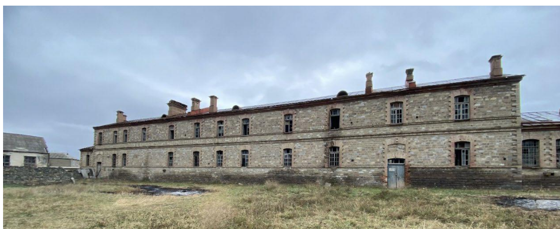
Фото 5. Общий вид Северного (главного) фасада Южного корпуса казарм (двухэтажный)
