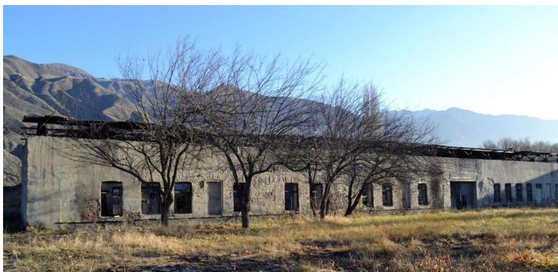
Фото 4. Общий вид юго-западного фасада Северного корпуса казарм
