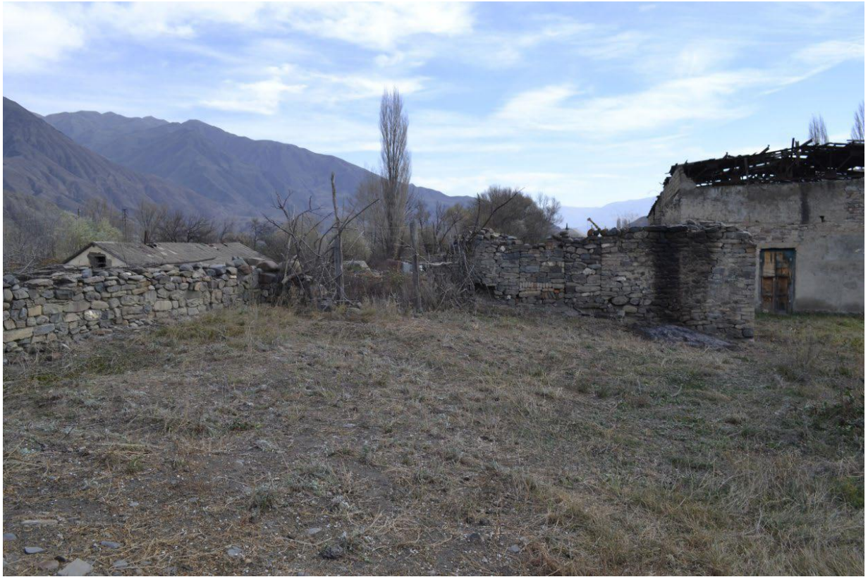
Фото 12. Вид с юго-запада на стены пятого бастиона с территории крепости
